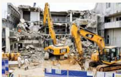
家庭科棟を解体 (平成23年)
